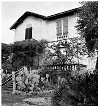
S'il passait ses étés à Mouthier (Doubs) Reyer aimait séjourner l'hiver au Lavandou, d'abord à l'hôtel puis dans sa maison construite en 1900. Elle fut rasée en 1996.
